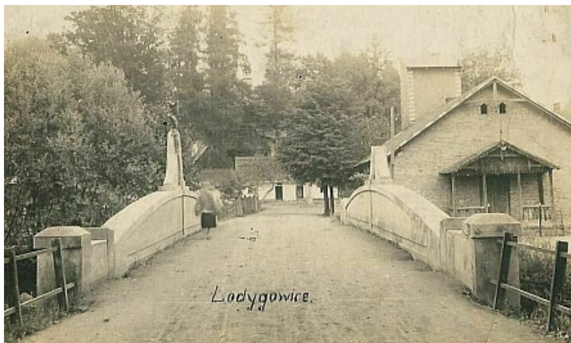
Zdj. 2 Stare zdjęcie mostu w Łodygowicach (źródło: www.lodygowice.pl )
